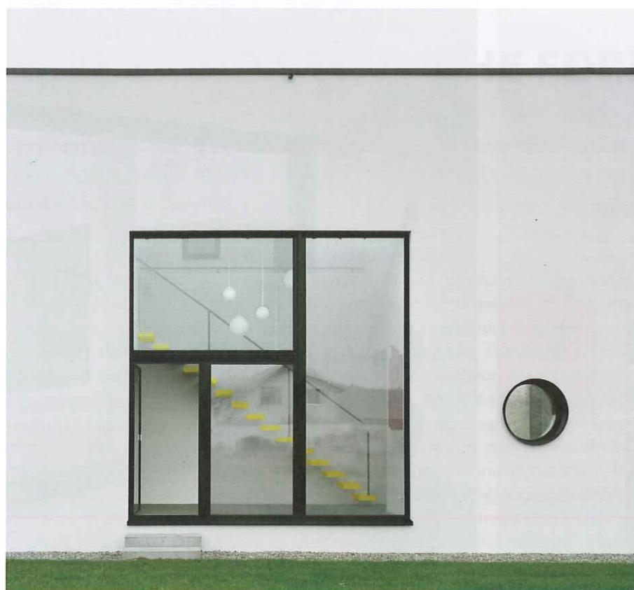
Die zweigeschossige Raumhöhe ist über eine grosszügige Öffnung in der Südfassade von aussen erkennbar.
